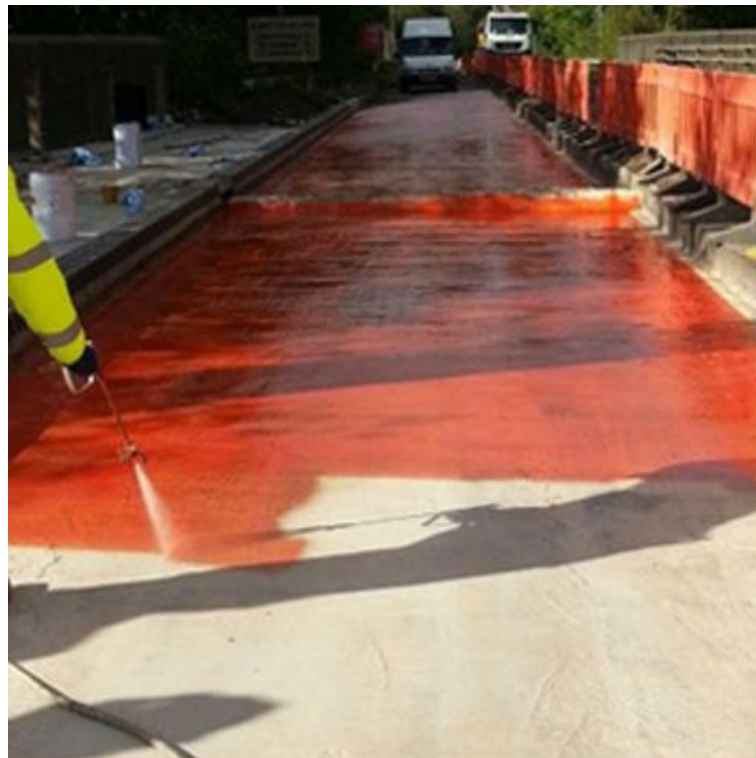
Második réteg Eliminator felhordása vasbeton szerkezeten
