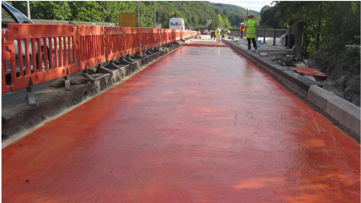
1. kép A Bond Coat 3 alkalmazása
