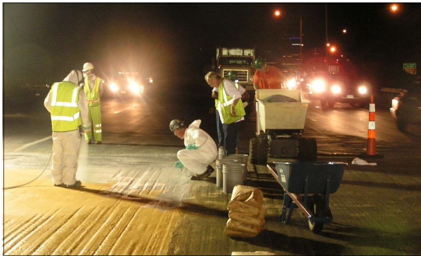
5. kép Nedvesvastagság mérés a második réteg Eliminator membrán felhordásakor
