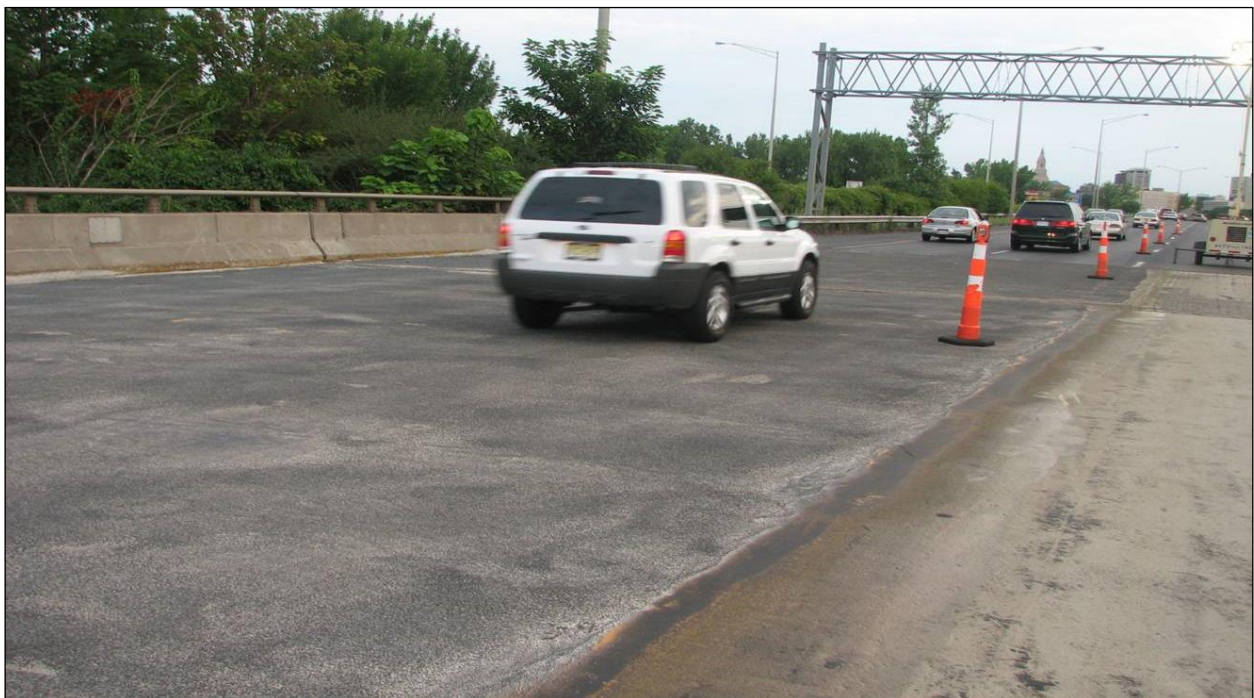
6. kép Forgalom az Interstate I-91 úton a csúszásmentesített szigetelő membránon
