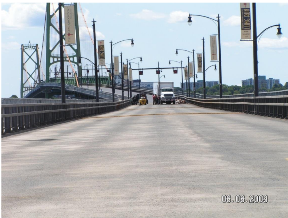
10. kép Aggregáttal szórt Eliminátor a MacDonald hídon
