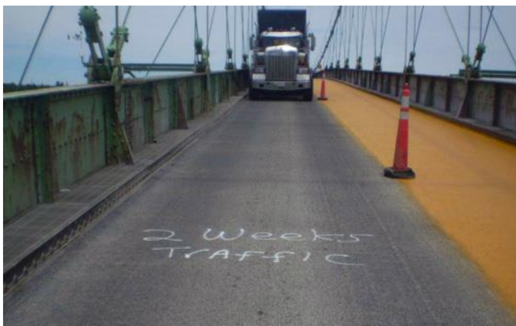
8.kép Aggregáttal szórt Eliminator két héttel a felhordás után a Deer Island hídon
