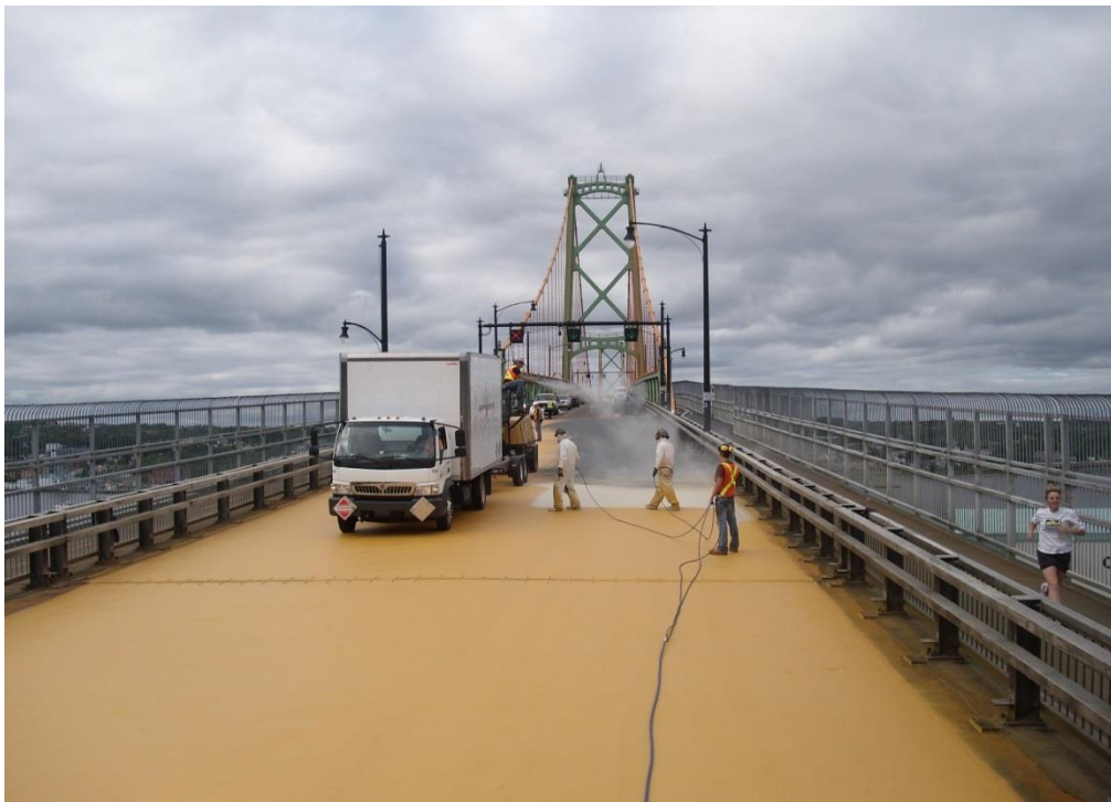
9. kép Eliminátor és aggregát felhordása a MacDonald hídon
